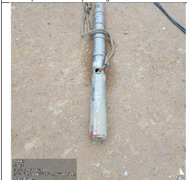
UBICACIÓN: Comunidad de Jururao, municipio de Uribia. FOTO No. 1 COMENTARIO: Cabezal del pozo y arreglo de tubería PVC utilizado para conducción y descarga.
