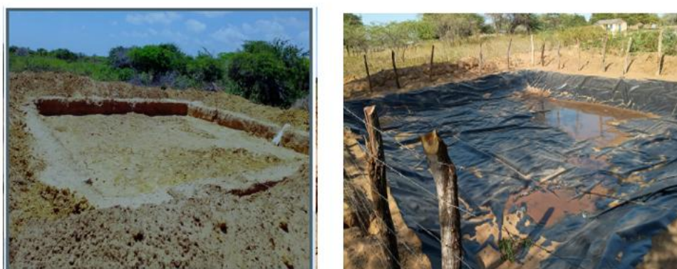
Ilustración 8. – Reservorio -Sistema de Acceso Agua - Jurura – Uribia
