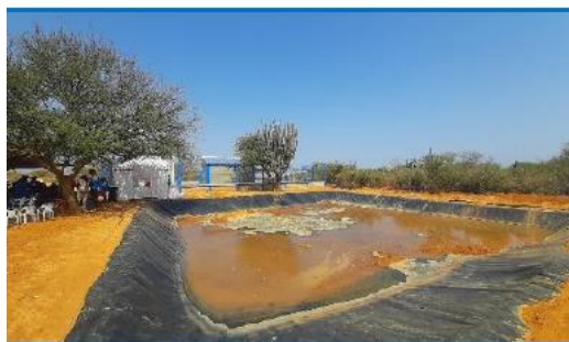
Ilustración 10. Reservorio – Sistema Acceso Agua - Pasipamana – Maicao
