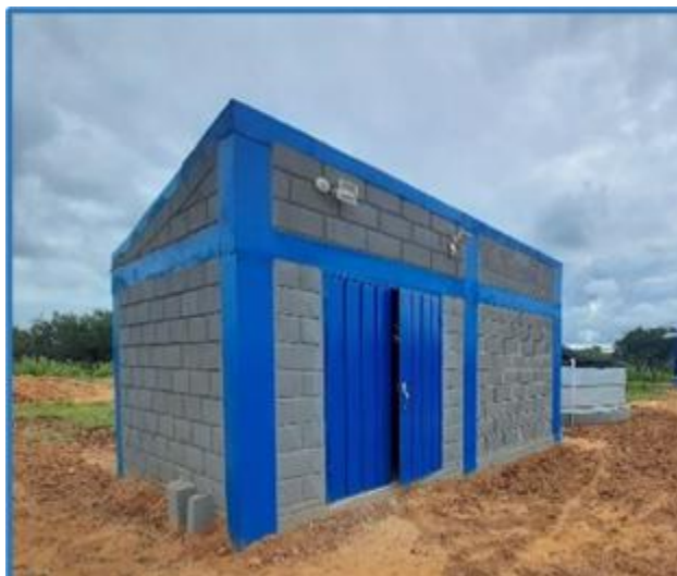
Ilustración 2. Caseta para Equipos – Sistema Acceso Agua - Pasipamana – Maicao
