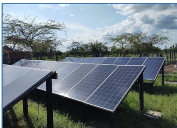
Ilustración 9. Diseño, suministro, e instalación de sistema de alimentación fotovoltaica con sus bases metálicas - Pasipamana – Maicao
