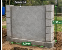
Muro para Dispensador de agua
