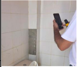
Reparacion de Enchape
