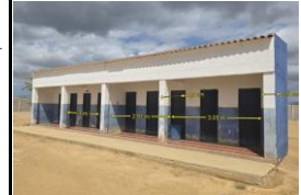
Restauracion de Puertas
