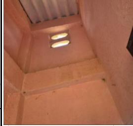
Pintura de Muros
