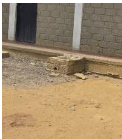
Ilustración 17. La imagen muestra una estructura en bloque de concreto ubicada en el área externa de la institución, evidenciando el espacio destinado para la construcción de registros de inspección.
