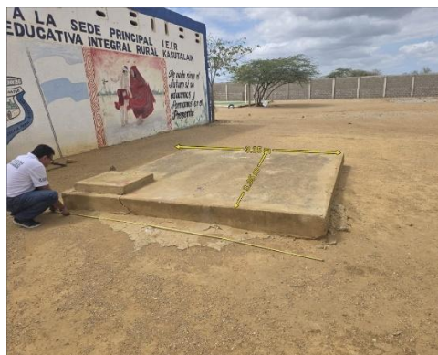
Ilustración 7. La imagen muestra el área externa de la institución con la estructura destinada al sistema de saneamiento, evidenciando las condiciones donde se realizará la intervención.
