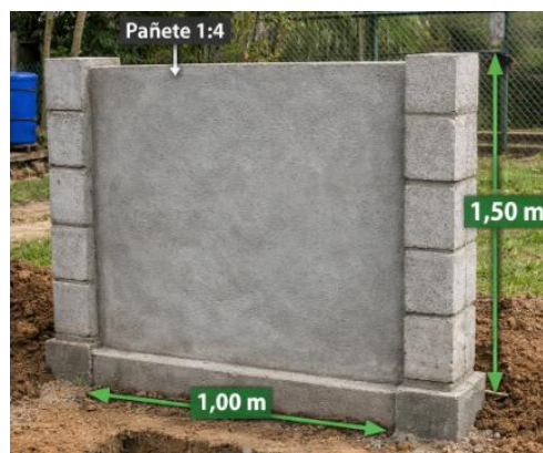
Ilustración 9. La imagen muestra un muro en bloque de concreto con columnas de confinamiento y acabado en pañete, evidenciando la construcción destinada a servir como soporte para un punto de hidratación. Este registro respalda la ejecución de cimentación, viga de base y pañete en mortero 1:4, garantizando estabilidad estructural y funcionalidad del sistema de agua.
