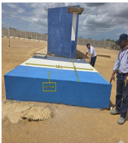
Ilustración 2. Condiciones de la alberca existente
