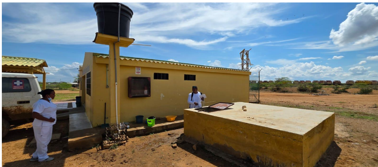
Ilustración 3. Zona de almacenamiento de agua y sistema de Bombeo.
