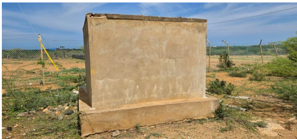
Ilustración 4. Alberca Antigua (Montaje de tanque de 500 litros sobre placa (altura 1.5 metros)
