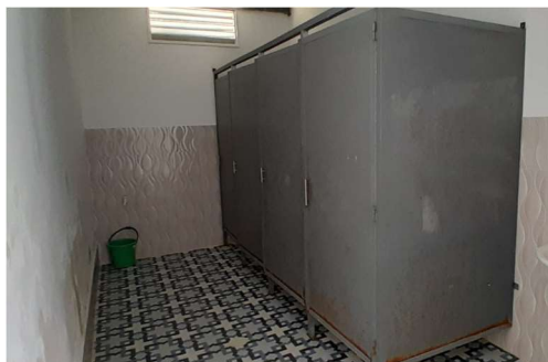
Imagen 6. Imagen de estado actual de las divisiones metálicas.
