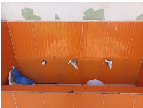
Imagen 6. Referencia lavamanos a rehabilitar.
