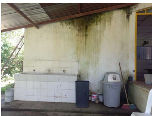
Imagen 5. Referencia bebedero a rehabilitar.
