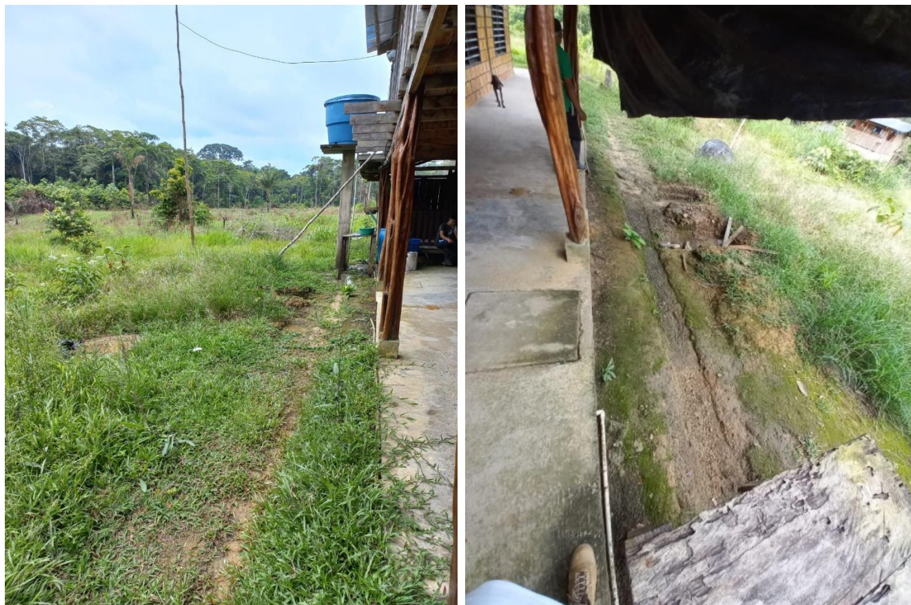
Imagen 01. Zona destinada para construcción de batería sanitaria, Casa Cabildo, ubicación lateral izquierda.
