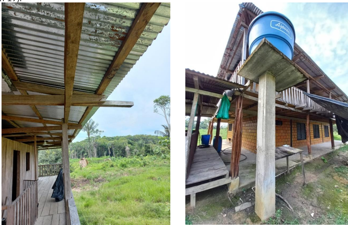
Imagen 18. Instalación de canales PVC y torre en corneto existente.
