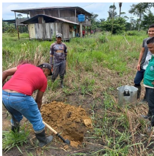
Imagen 16. Ubicación pozo de infiltración.
