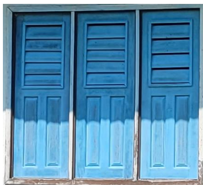
Ilustración 31. Ventana existente actualmente.
