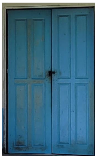
Ilustración 32. Puerta existente en sitio.
