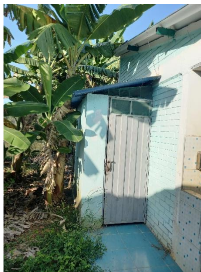
Imagen 25. Puertas exteriores existentes
