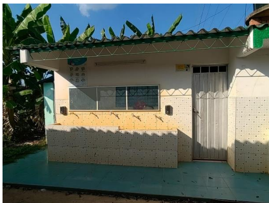
Imagen 20. Muros exteriores existentes
