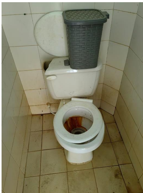
Imagen 7. Enchape de piso y muro (0,20*0,20) m Blanco actualmente en la batería sanitaria
