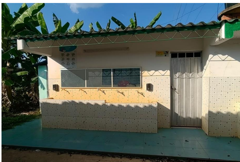
Imagen 27. Vista frontal de la cubierta de la batería sanitaria
