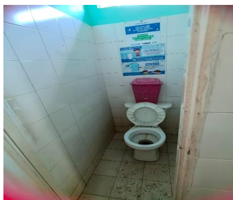
Imagen 23. Muros interiores existentes
