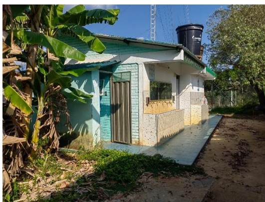
Imagen 21. Muros exteriores existentes
