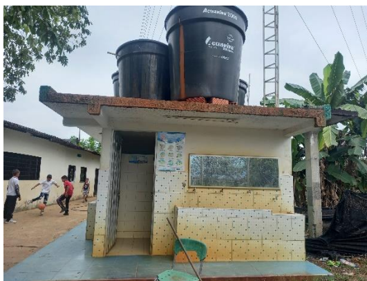
Imagen 19. Muros exteriores existentes
