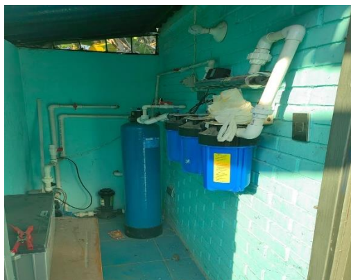
Imagen 22. Muros interiores existentes
