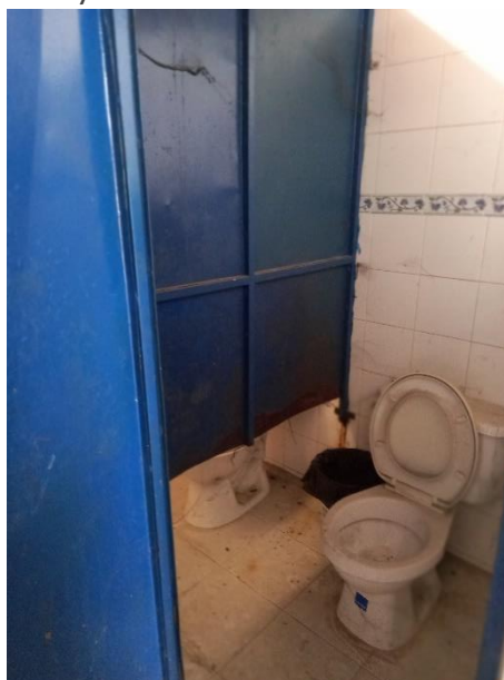
Imagen 27. Puertas y divisiones metálicas existentes batería bloques
