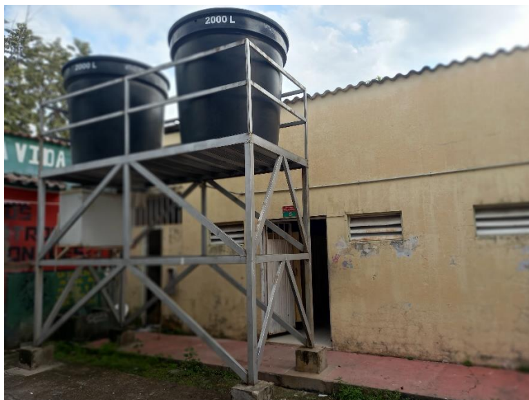
Imagen 24. Muros exteriores existentes
