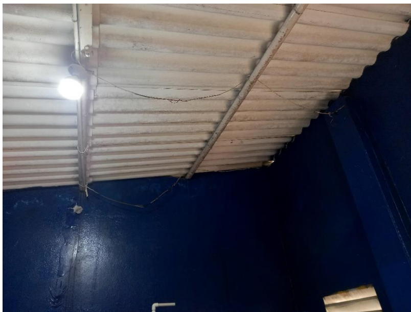
Imagen 28. Tubería metálica cubierta baño niñas
