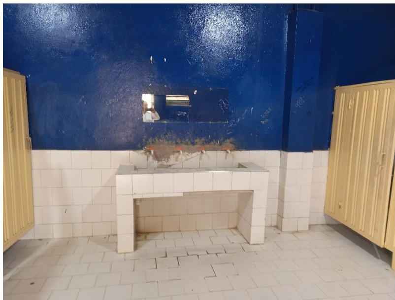
Imagen 26. Puertas y divisiones metálicas existentes batería niñas
