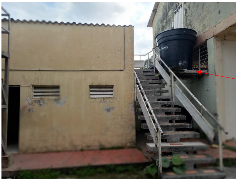
Imagen 31. Estructura de soporte tanques adyacente a la batería sanitaria niñas
