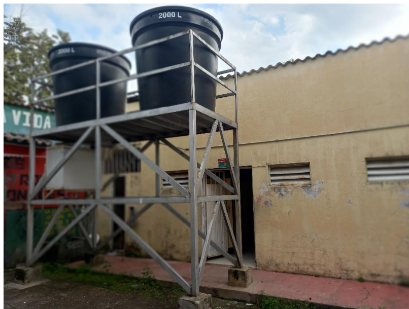
Imagen 29. Estructura de soporte tanques batería sanitaria niñas
