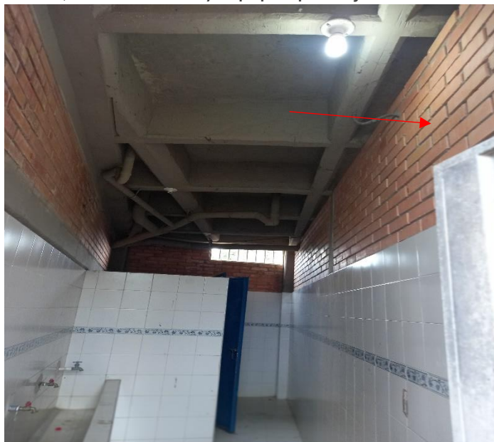
Imagen 9. Vista muro a confinar con la viga corona
