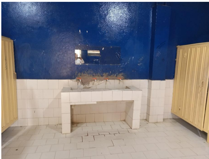
Imagen 25. Muros interiores existentes
