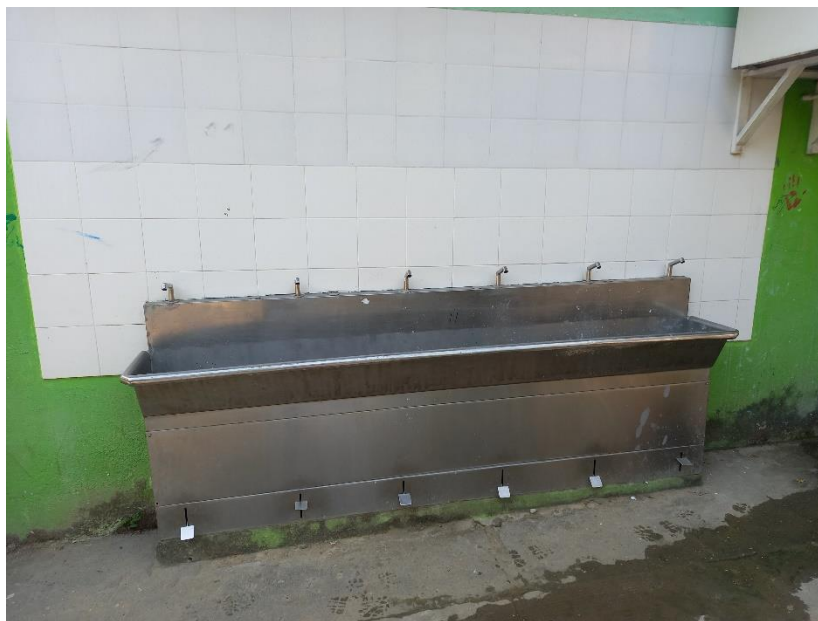
Imagen 21 Punto de hidratación 2 existente
