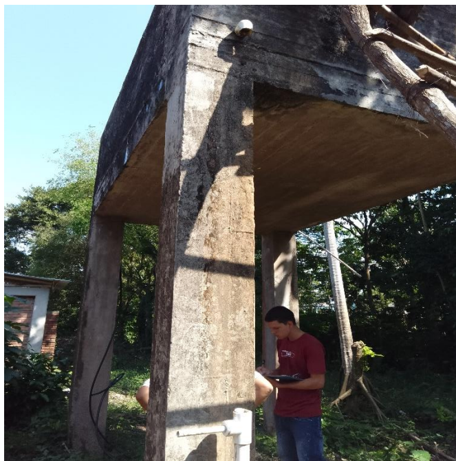
Imagen 13. Torre de almacenamiento de agua existente
