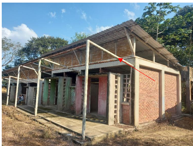
Imagen 19. Estructura de la cubierta existente
