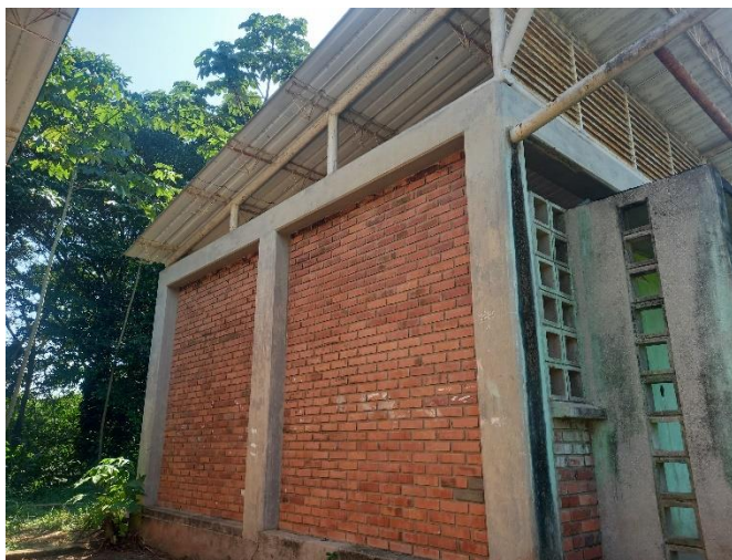
Imagen 15. Muros en ladrillo a la vista para impermeabilizar
