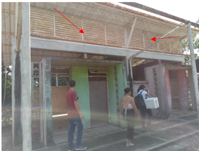
Imagen 18. Ubicación de las rejillas frontales para pintar
