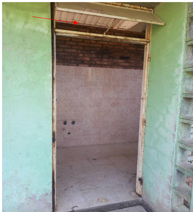
Imagen 5. Zona para realce de muro en los módulos sanitarios independientes
