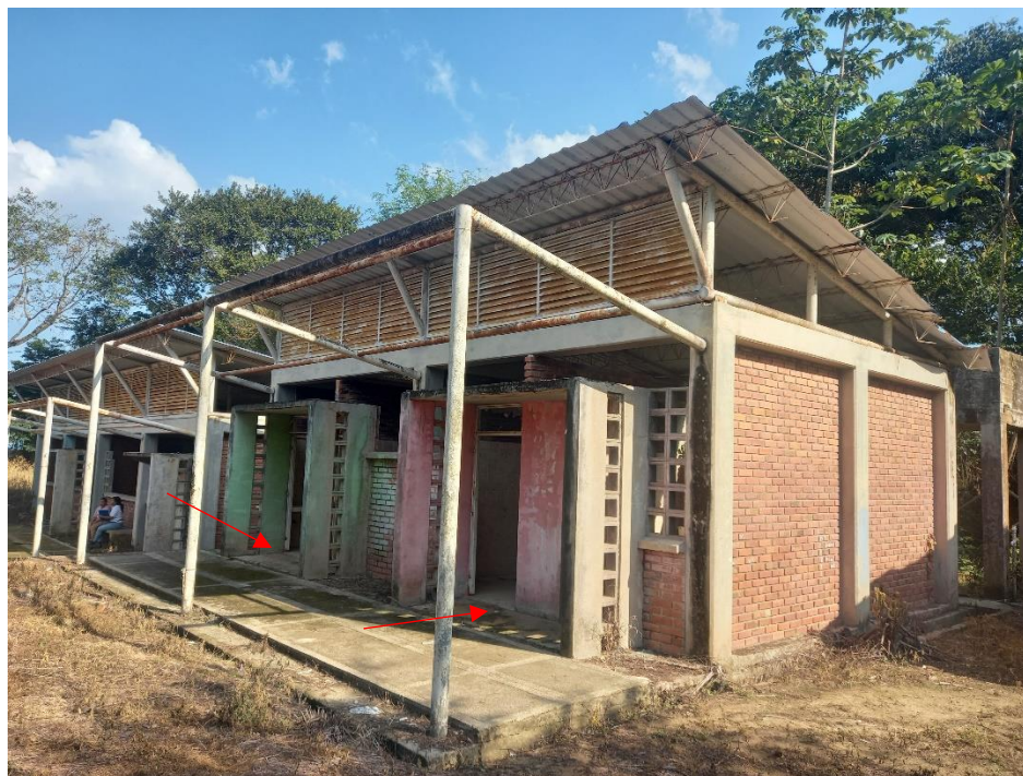
Imagen 4. Losas en concreto a demoler.
